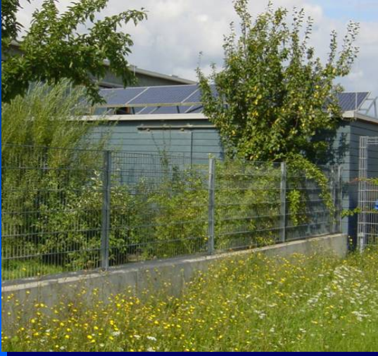
Photovoltaïque sur le toit du carport de l'école primaire
